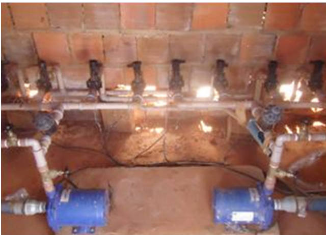
Figura 1. Fotografia do conjunto de irrigação pressurizado no Assentamento Milagres em Apodi-RN, detalhando reservatório para esgoto doméstico (A), reservatório para água de abastecimento (B), conjuntos motobomba com filtros de discos (C) e unidades de irrigação por gotejamento (D)
