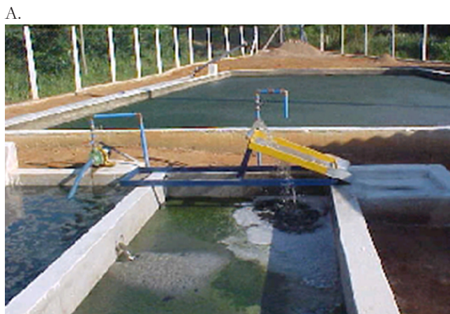
Figura 1. Sistema de filtração. Vista lateral (A) e abastecimento da peneira com efluente (B)
