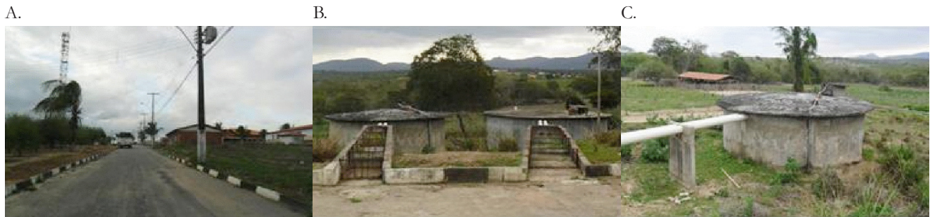
Figura 2. Estrada pavimentada com asfalto no interior do Campus do IF Baiano (A); detalhes do sistema de filtragem antes da água chegar às cisternas (B) e detalhe da cisterna abastecida com escoamento superficial da água do asfalto
