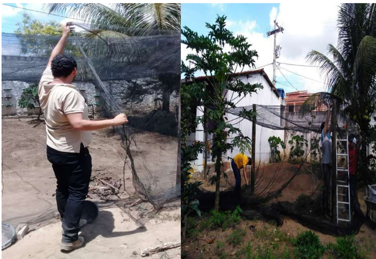
Figura 2: Instalação do telado sombrite na área da horta.
