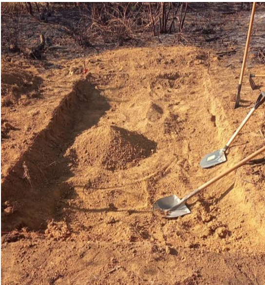
Figura 2. Escavação da Bacia de Evapotranspiração em fase inicial
