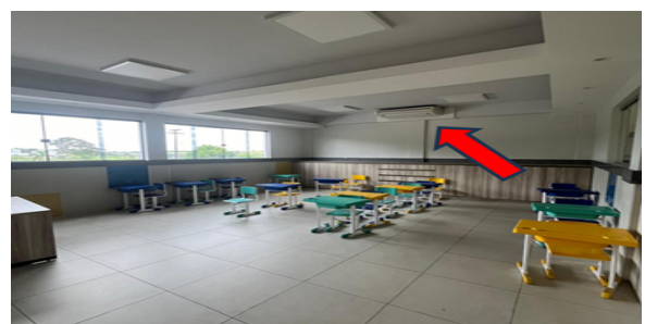
Figura 6. Sala de aula com o uso da ventilação artificial.
