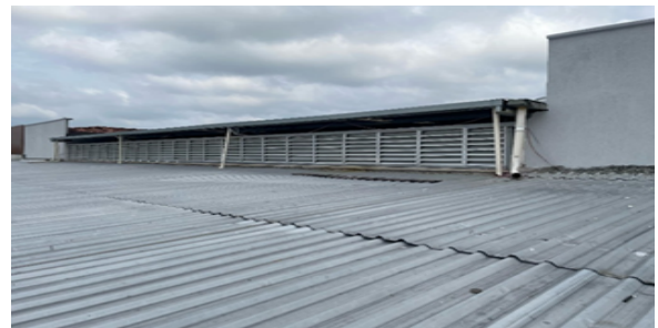
Figura 4. Sistema de ventilação natural por lanternim na área de convivência (vista externa).
