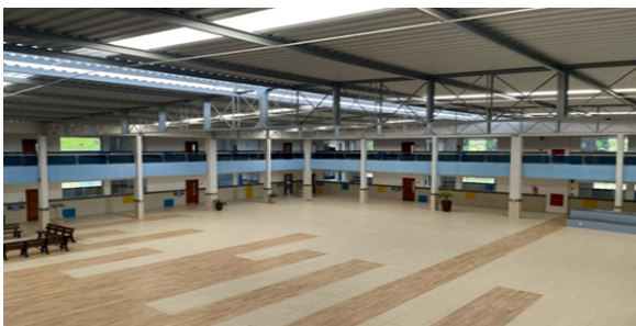
Figura 2. Vista interna da área de convivência da unidade escolar (1º pavimento).
