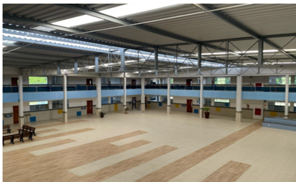
Figura 2 – Vista interna da área de convivência da unidade escolar (1º pavimento).
