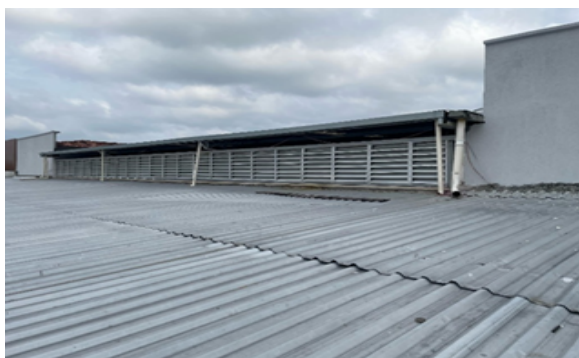
Figura 4 – Sistema de ventilação natural por lanternim na área de convivência (vista externa).
